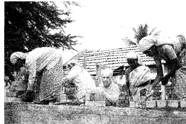
Werner Dahlmanns leitet die Frauen auf der Baustelle an. Mitten in den Slums entsteht ein Steinhaus.
